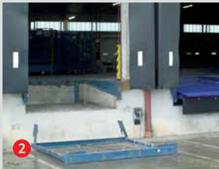
Se demontează rama veche
