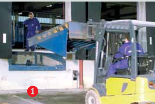
Se demontează rampa veche
